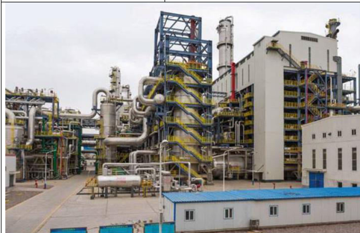
Fig. 5b. Instalația pilot industrial de conversie a metanolului la olefine și benzină sintetică (MTO/MTG) de la Combinatul Petrochimic Brazi (Ploiești, România), dată în funcțiune în 1985 de un colectiv de cercetători și ingineri proiectanți de la IECB (ICECHIM) și IITPIC (București). Sistemul de două reactoare catalitice în strat fluidizat a fost proiectat tehnologic de către câțiva membri ai colectivului de Reactoare chimice de la Univ. Politehnica din București condus de Prof. dr. ing. Raul Mihail. Descrierea sumară a proiectului a fost făcută de către un inginer cercetator-proiectant cheie al proiectului [Maria, G., From residual biomass and inferior quality coal to the synthesis of methanol and then to hydrocarbons and gasoline – a Romanian project of high success, Juniper, Irvine California USA, 2018, ISBN 978-1-946628-16-9; vezi cartea nr.9 de mai sus]. Descrierea în extenso a fost făcută de către dr. G. Maria ca fiind inginerul cheie al proiectului, respectiv cel care a elaborat modelele cinetice ale proceselor catalitice și le-a folosit la proiectarea tehnologică a sistemului de 2 reactoare catalitice cu transport pneumatic continuu între ele [Maria et al., 2020](cartea nr. 11 din lista de mai sus).
